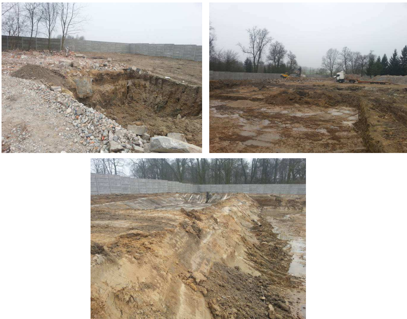
Zdjęcia 5.2 - 8-10 widok istniejących na terenie wykopów opisanych powyżej
