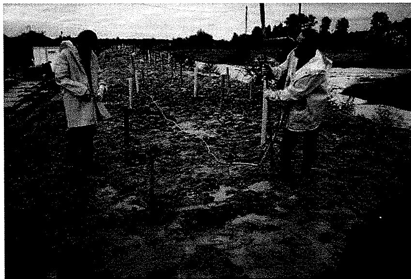
Rys.6.1.1 - 2 przykładowy widok przyzmy bioremediacji z zamontowanym systemem napowietrzania
