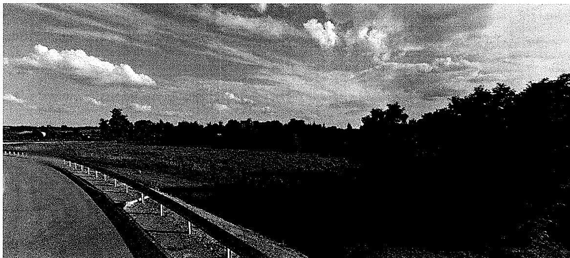
Zdjęcie 5.1- 3 widok na tereny graniczące z obszarem inwestycji od strony wschodniej.
